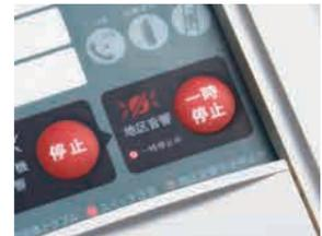
受信機通常の監視状態に復旧させるにはシーリングパネルを開けて復旧スイッチを押します。
