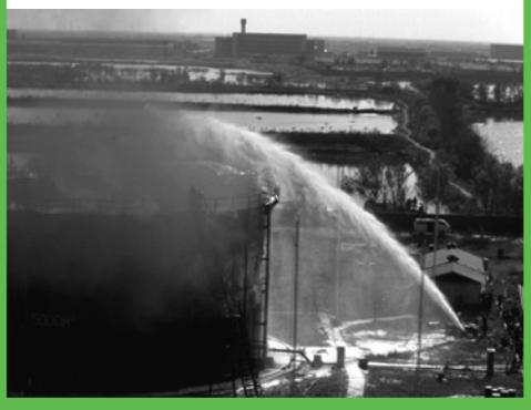
泡消火設備は引火性液体を対象とし、主に危険物取扱所および製造所・貯蔵庫、駐車場などに設置されます。水と消火薬剤を比例混合した水溶液を泡放出口より空気を含むエアフォームとして散布し、燃焼面を覆い空気をしゃ断するとともに冷却効果で消火を行います。設備は水源・加圧送水装置・原液槽・混合器・発泡器・制御盤・配管・配線などによって構成されます。
