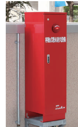
移動式粉末消火設備
