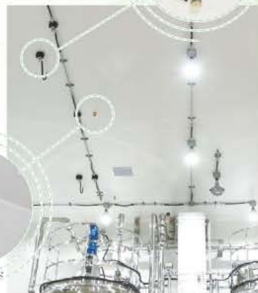
工場棟内（タンク室天井）
