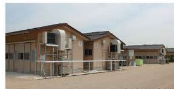
空調設備が完備された既舎
