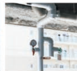
末端試験弁
