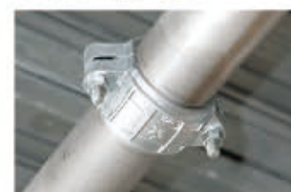
ハウジング形管継手
