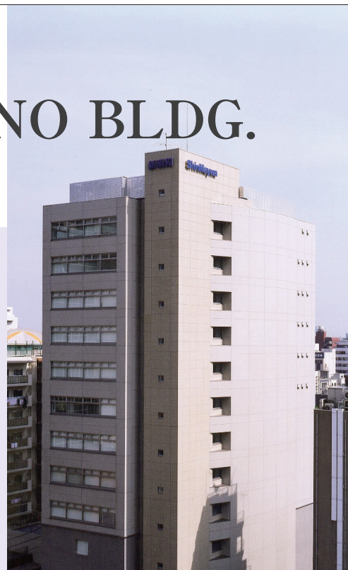
新明和上野ビル外観
