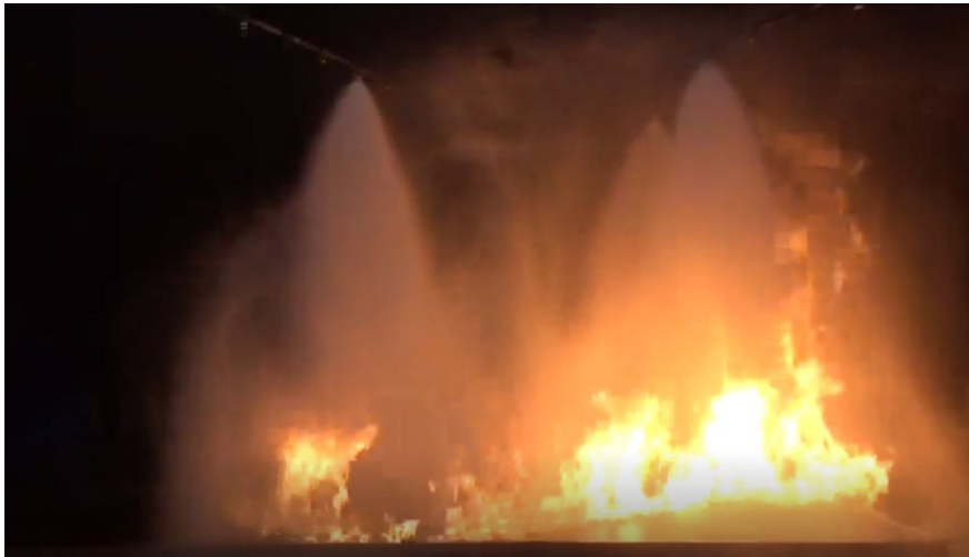
消火実験の様子
