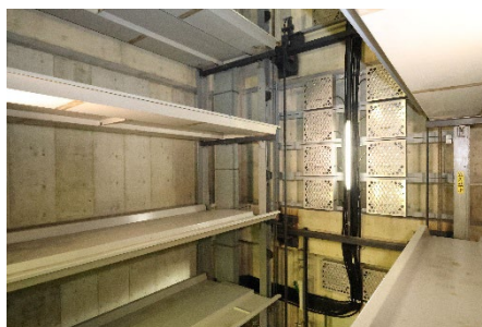
K/SMOKE GAS 放射器
