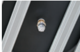
閉鎖型スプリンクラーヘッド
