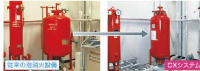
●従来の泡消火設備との比較写真(泡タンクのサイズダウン)
