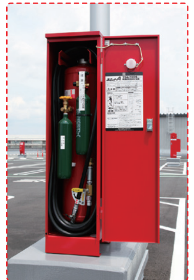
移動式粉末消火設備
