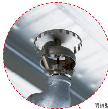
閉鎖型泡水溶液ヘッド
