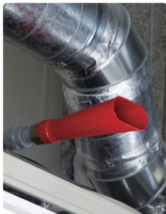
窒素消火設備噴射ヘッド
