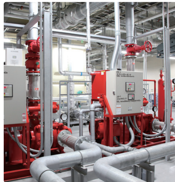
スプリンクラーポンプ室
