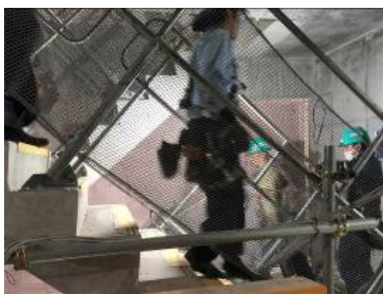
写真1 避難経路を通り避難する作業員
