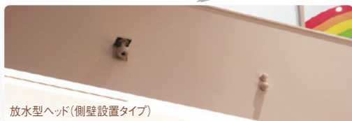
放水型ヘッド（側壁設置タイプ）
