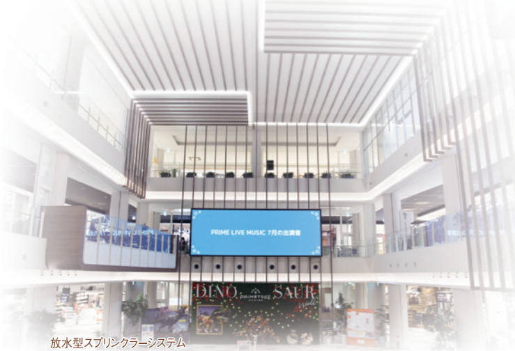
放水型スプリンクラーシステム
